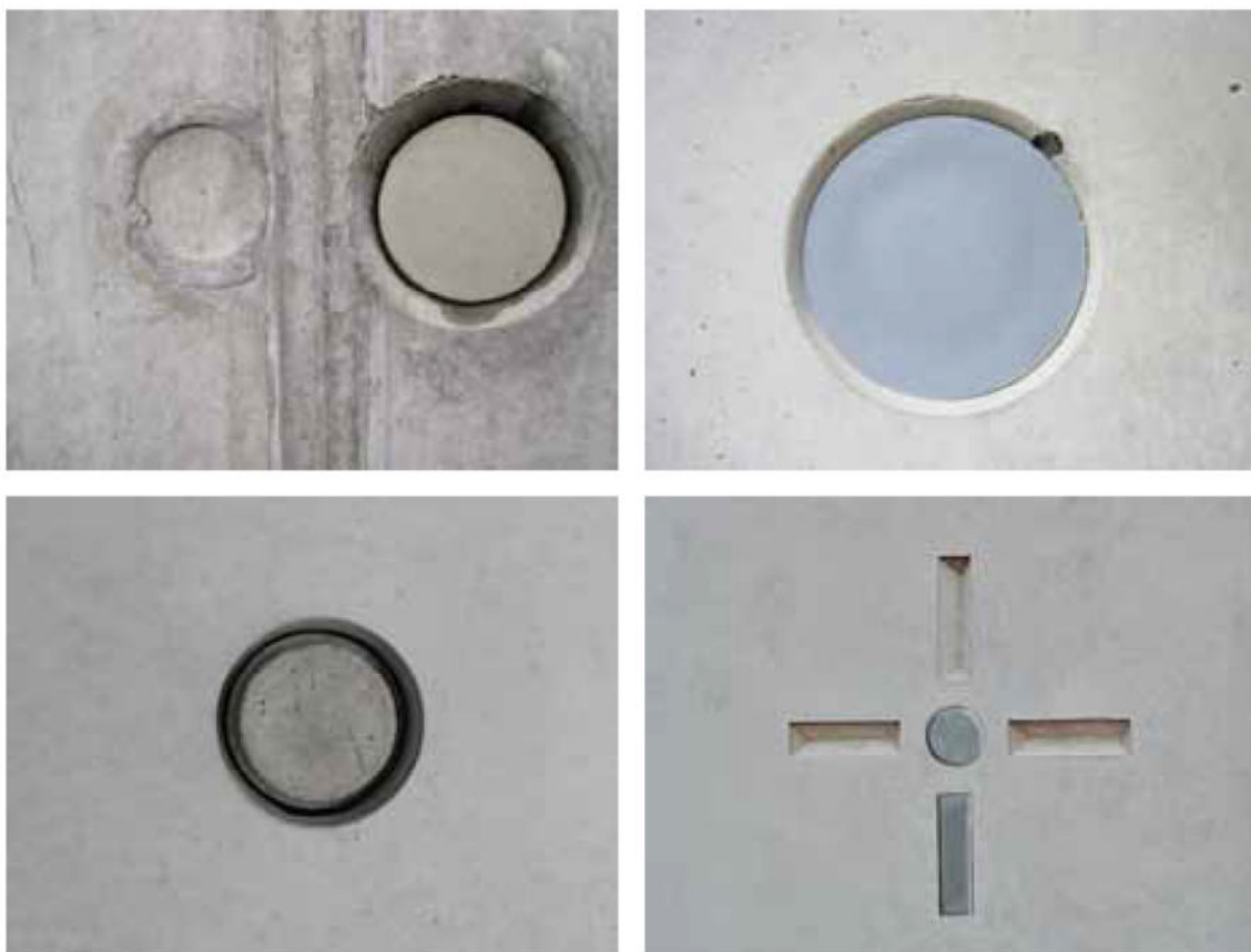
(23) Obr. F.2 – Různé způsoby uzavření spínacích otvorů
